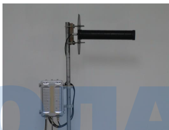
Рисунок 9. Монтаж системы (антенна с круговой поляризацией).
